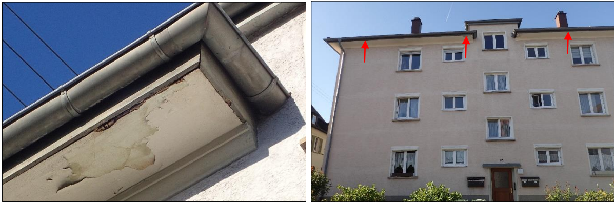
Abbildung 5: Hölzerner Traufkasten mit Potenzial für Mauersegler an den Gebäuden Ludwig-Herr-Straße 16/1 (linkes Bild) und Oststraße 30-32 (rechtes Bild, rote Pfeile) im nördlichen Quartier.
