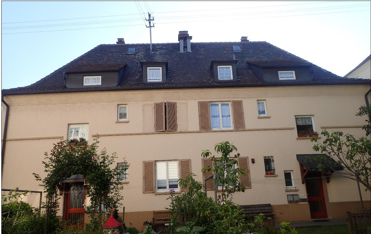
Abbildung 6: Eines der Wohnhäuser in der Ludwig-Herr-Straße 14-20 mit potenziell durch Fledermäuse nutzbaren Fensterläden.
