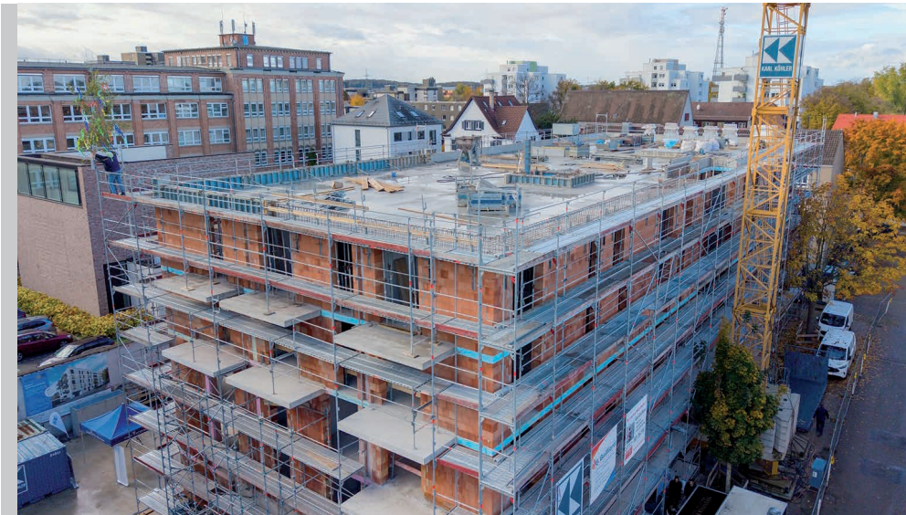
Das Gebäude in der Poststraße, hier beim Richtfest im Oktober 2025, soll bereits in diesem Sommer bezogen werden.
