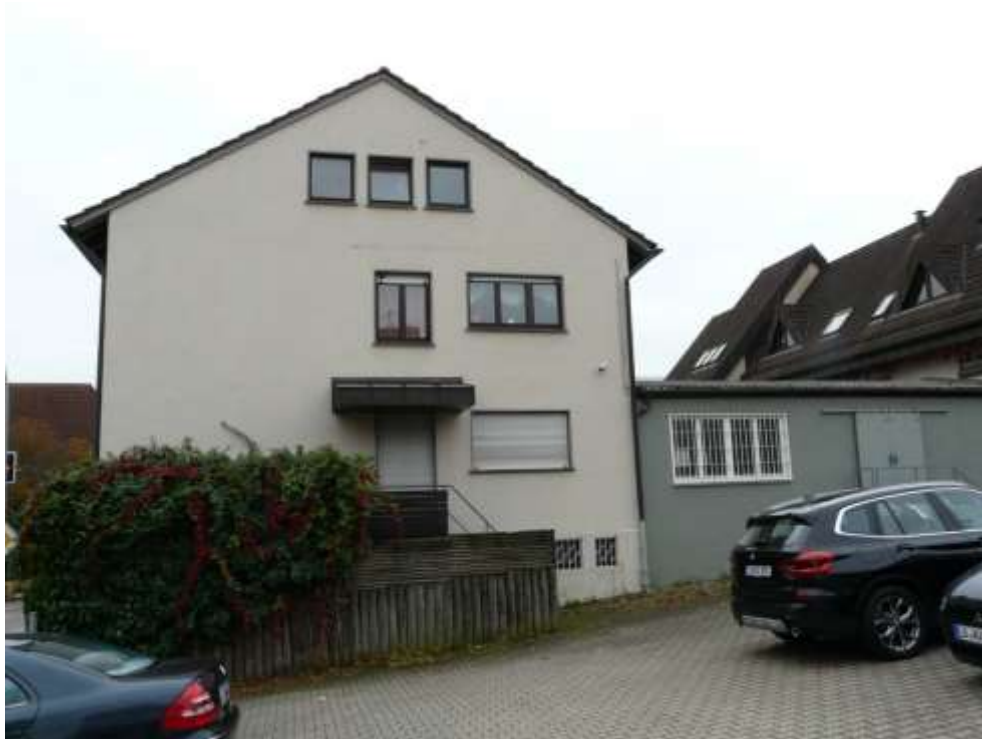
Abbildung 18 und 19: Nordfassade der Gebäudes Ludwigsburger Straße Nr. 1 und 3.
