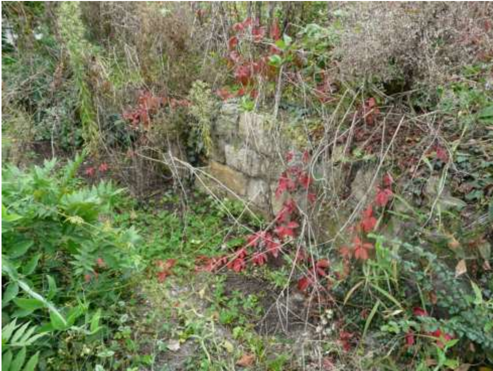
Abbildung 10: Verfugte und teilweise überwucherte Natursteinmauer auf dem Grundstück Flst. Nr. 4.
