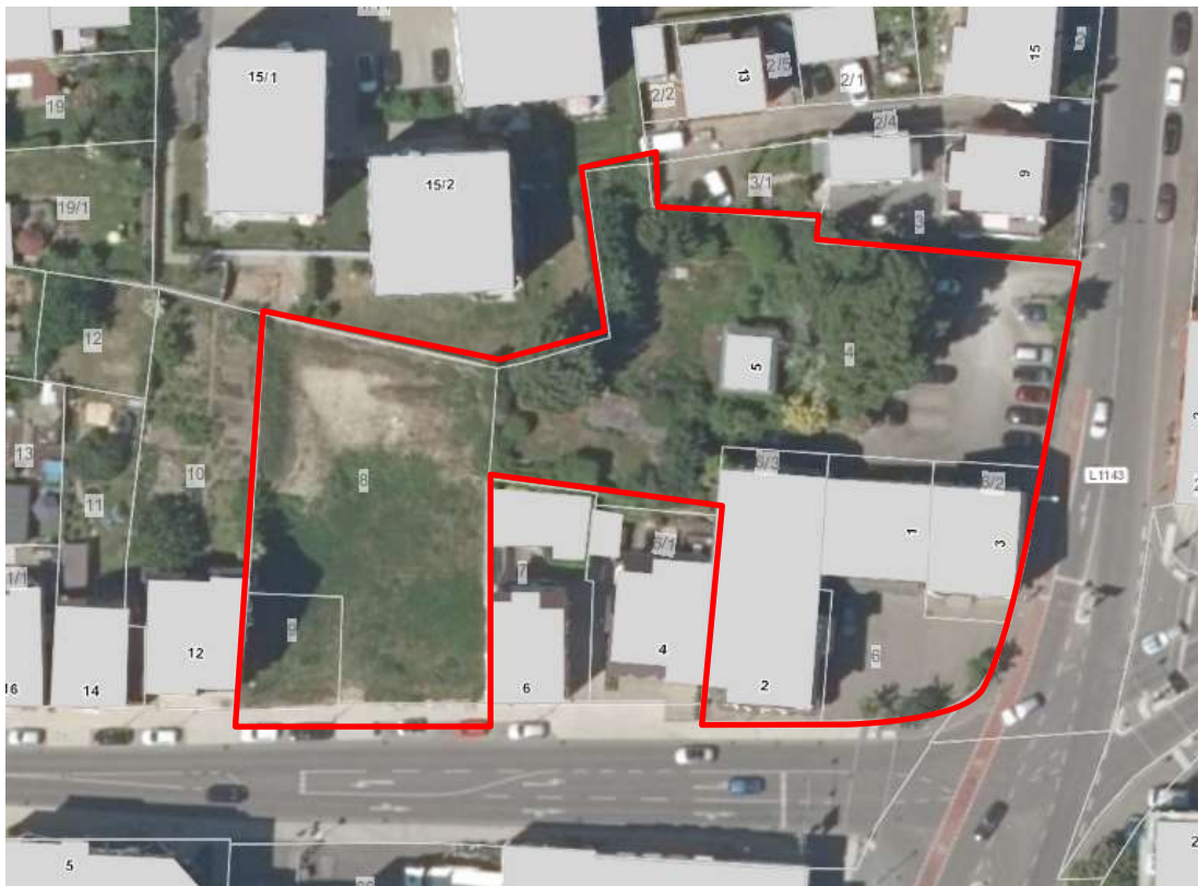
Abb. 2: Darstellung des Plangebiet (Luftbildgrundlage: Orthofoto Daten- und Kartendienst LUBW). Das zeigt den Zustand im Jahr 2020 vor der Entfernung der Gehölzbestände.
