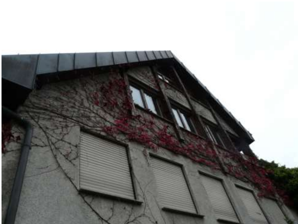
Abbildung 8 und 9: Nordfassade des Gebäudes Jakobstraße Nr. 2.
