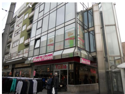
Foto 39: Beispiel vertikale Steuerung - Vergnügungsstätte im Obergeschoss
