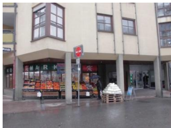
Foto 18: Nachbargebäude Spielhalle Güterbahnhofstr. 28
