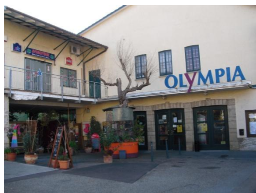
Foto 40: Beispiel vertikale Steuerung - Vergnügungsstätte im Obergeschoss
