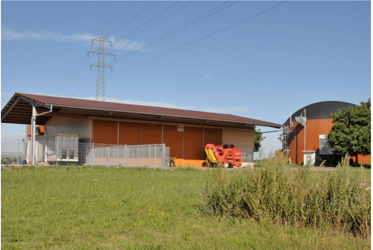
Abb. 30: Biogasanlage Römerhügel Kornwestheim (Bildquelle: www.kwa-ag.de )
