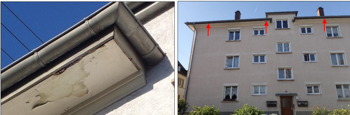
Abbildung 6: Hölzerner Traufkasten mit Potenzial für Mauersegler an den Gebäuden Ludwig-Herr-Straße 16/1 (linkes Bild) und Oststraße 30-32 (rechtes Bild, rote Pfeile) im nördlichen Quartier.
