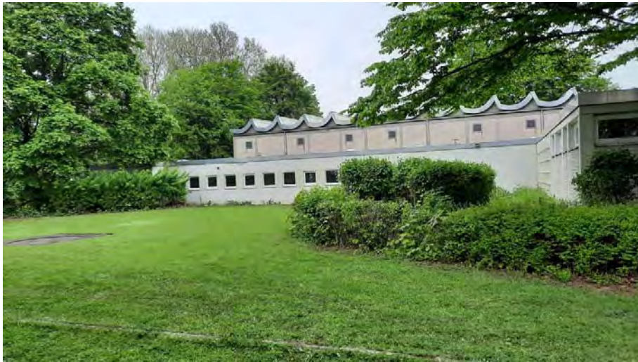
Abb. 6: Alte Sporthalle, Ansicht aus Süden
