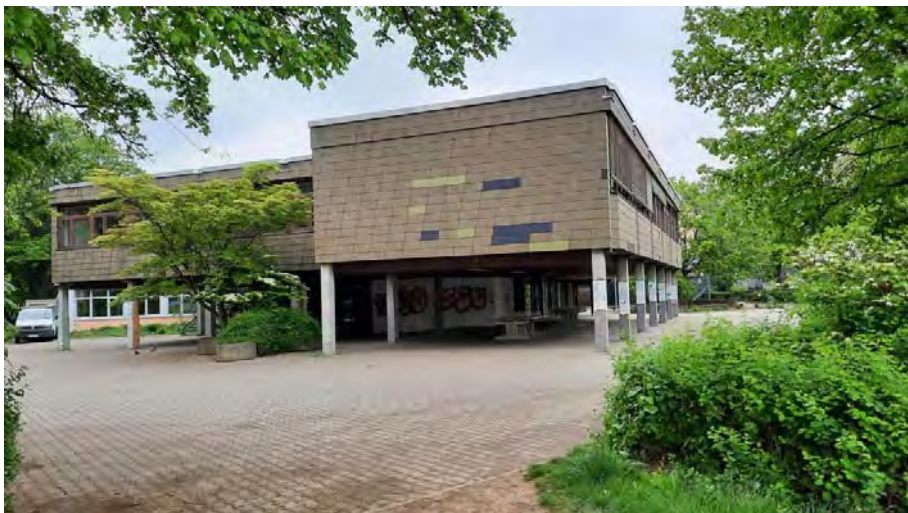
Abb. 4: Schulanbau südlich am Hauptgebäude
