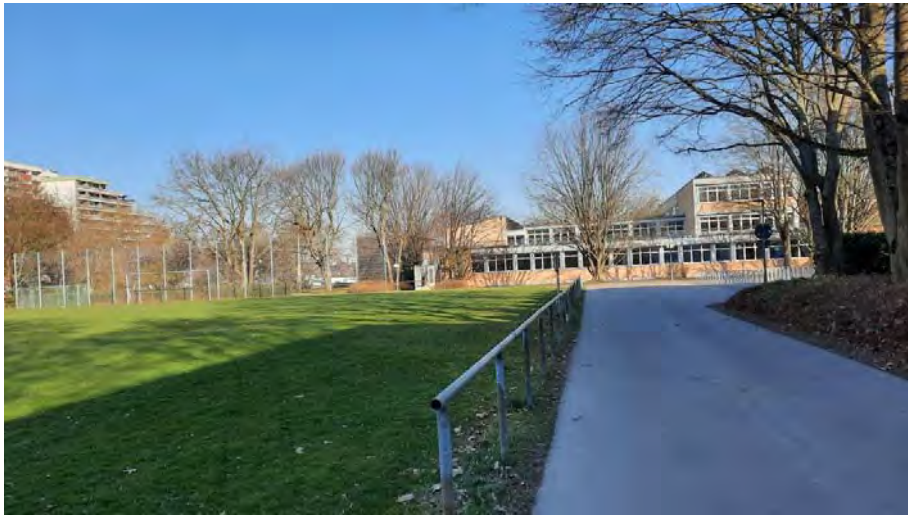
Abb. 2: Sportplatz und Schulgebäude/Westseite
