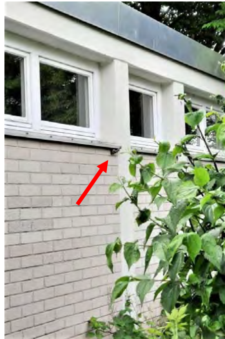
Abb. 12: Blaumeise beim Einflug in den Brutplatz in einem Hohlraum hinter dem Fenstersims
