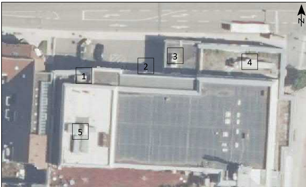
Abbildung 5 – Luftbild: Dach des Wette Centers 3
