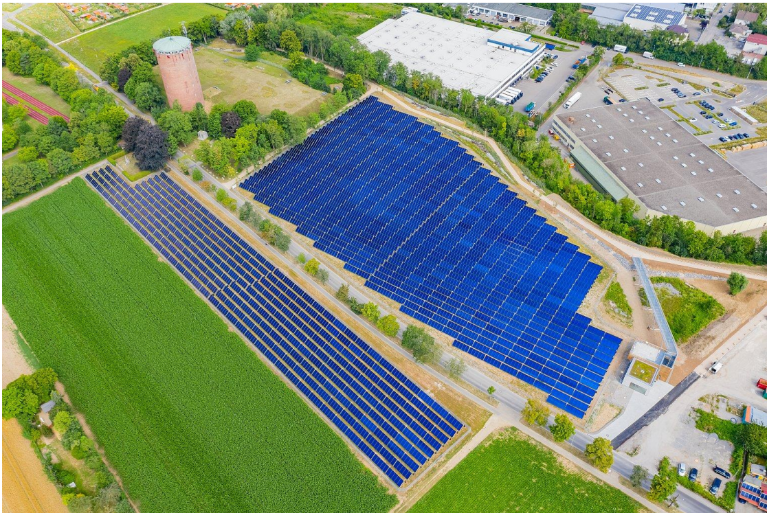
Abb. 27: Solarthermieanlage auf Ludwigsburger und Kornwestheimer Gemarkung
